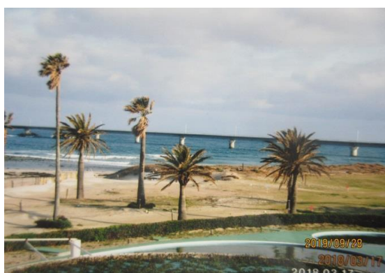
日本最西北端 山口県角島大橋
