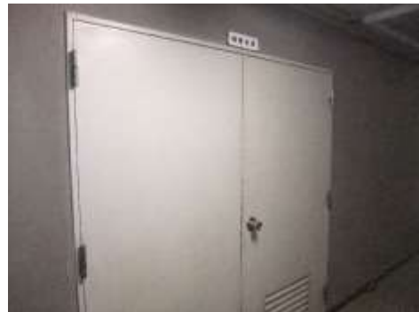
地下備蓄倉庫
