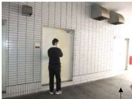
本館奥側の倉庫(1F)
