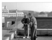
アンテナ設置は安全第一
