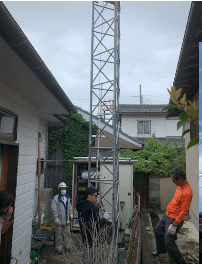
クランクアップタワー 移設・建柱
