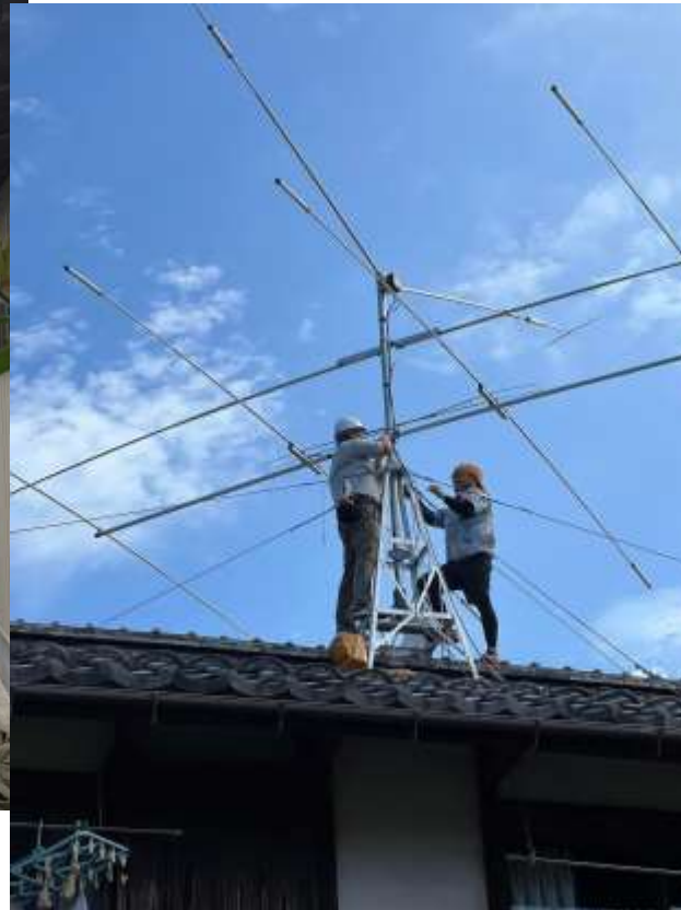
ルーフタワー建設 HF(7~28MHz)取付
